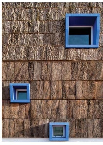
Figura 10 Fachada ventilada / Estereotomia, texturas e cores (azul Coruche)
