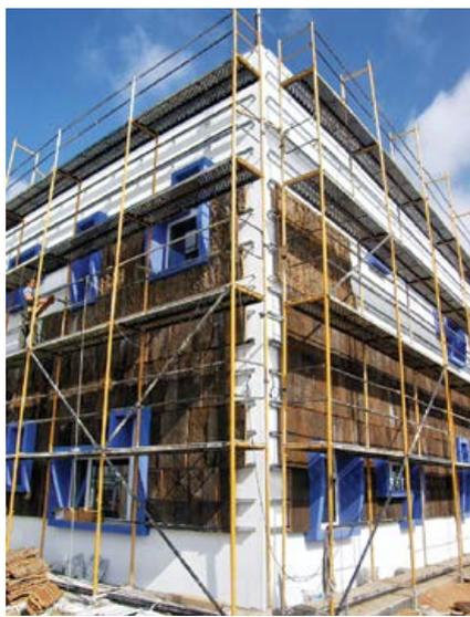
Figura 8 Fachada ventilada / construção
